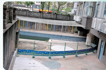
泳池周邊修繕工程竣工，營造更安全舒適的活動環境。
