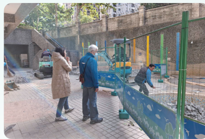
徐朝宗會長（左二）與林湘雅執行長（左一）勘查泳池周邊修繕工程。
